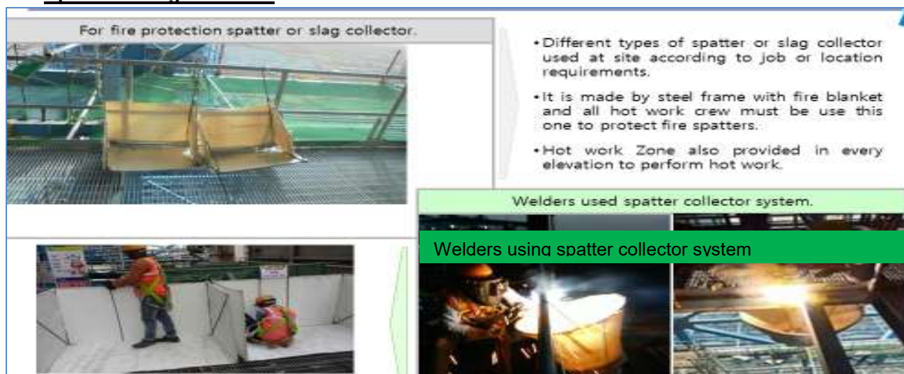
Fig. 13.2.3.1 Splatter / Slag Collector
