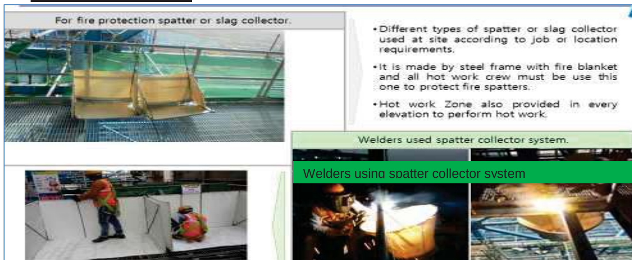
Fig. 13.2.3.1 Splatter / Slag Collector
