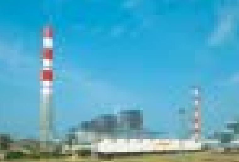
भारत का सबसे बड़ा विद्युत स्टेशन 3,200 मेगावाट विंध्याचल एसटीपीएस बीएचईएल के प्रत्येक 500 मेगावाट के 4 सेटों से सज्जित है।
