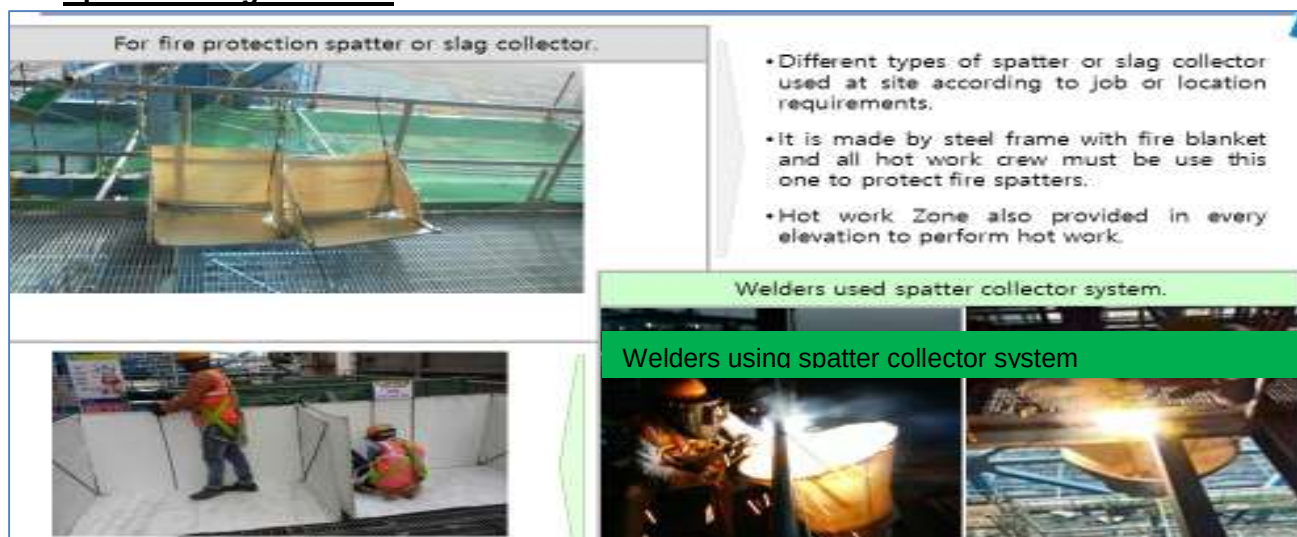
Fig. 13.2.3.1 Splatter / Slag Collector
