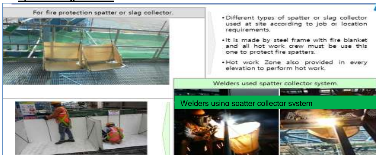
Fig. 13.2.3.1 Splatter / Slag Collector
