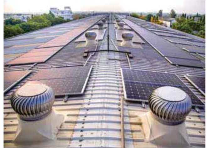
हैदराबाद, तेलंगाना में बीएचईएल द्वारा चालू किया गया 180केवी रूफटॉप सोलर पीवी संयंत्र
