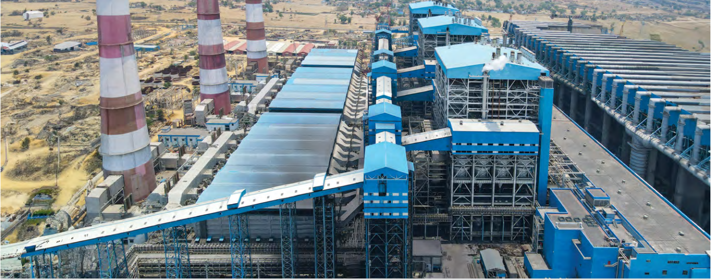
बीएचईएल ने एनटीपीसी नॉर्थ करनपुरा सुपर थर्मल पावर प्रोजेक्ट यूनिट-2 (3x660 मेगावाट) में एयर कूल्ड कंडेंसर (एसीसी) से सुसज्जित देश का पहला यूटिलिटी-स्टेल्स थर्मल पावर प्लांट कमीशन किया।
