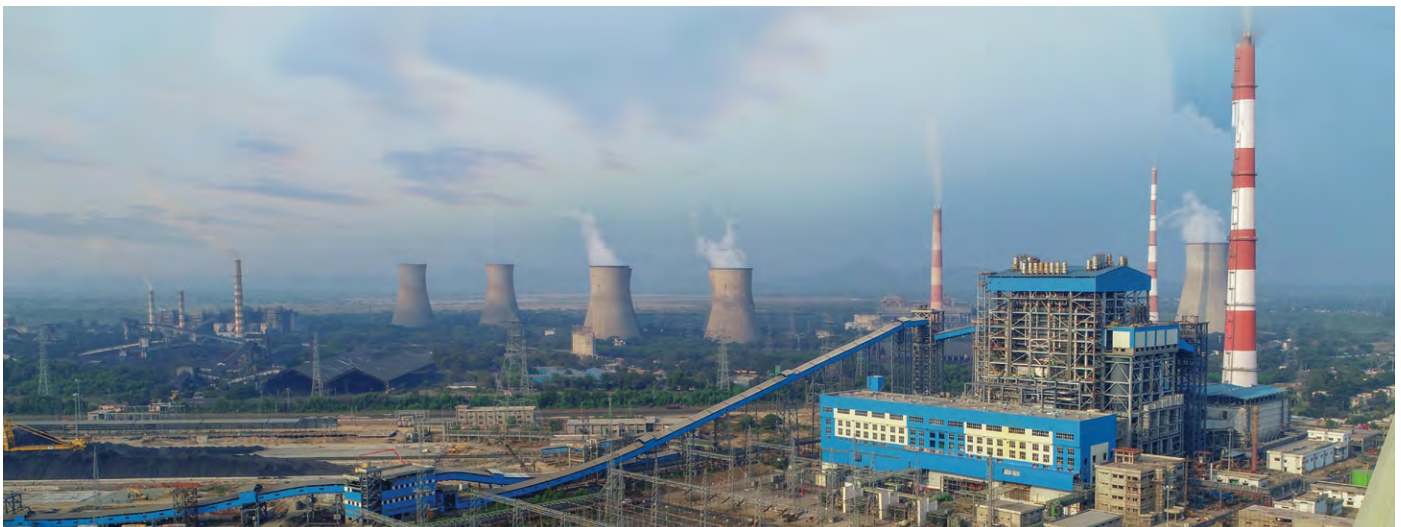
बीएचईएल ने एनटीपीसी नॉर्थ करनपुरा सुपर थर्मल पावर प्रोजेक्ट यूनिट-2 (3x660 मेगावाट) में एयर कूल्ड कंडेंसर (एसीसी) से सुसज्जित देश का पहला यूटिलिटी-स्केल थर्मल पावर प्लांट कमीशन किया।
