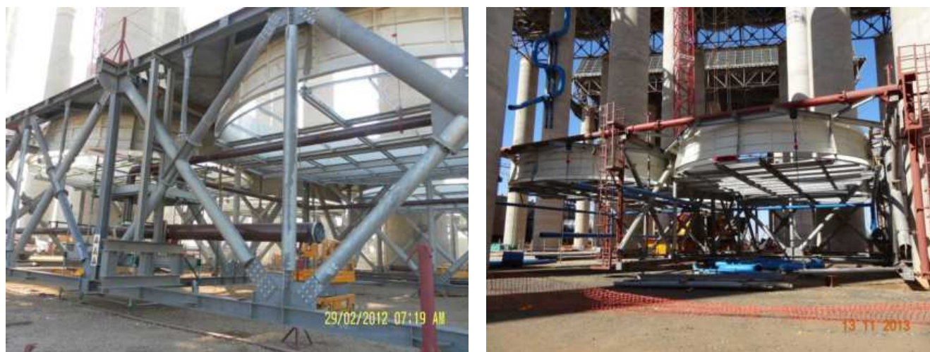
Modules Lifting devices-lugs SWL 50 Ton
