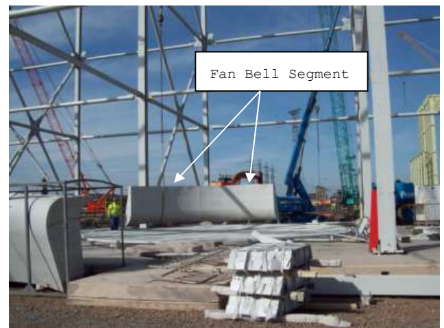
Section 6. Assemble of fan screen & FRP Fan bell
