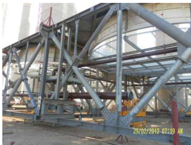
Modules Lifting devices-lugs SWL 50 Ton
